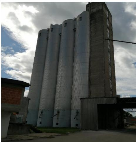
Silos je izgrađen 1979. godine. Dimenzije silosa su 12,50 x 24,90 m i visine 48,30 m, spratnosti P+10. Silos se sastoji od osam okruglih čelija prečnika 6 m, sa tri međučelije, te mašinskim dijelom. Kapacitet silosa je 7000 tona.
