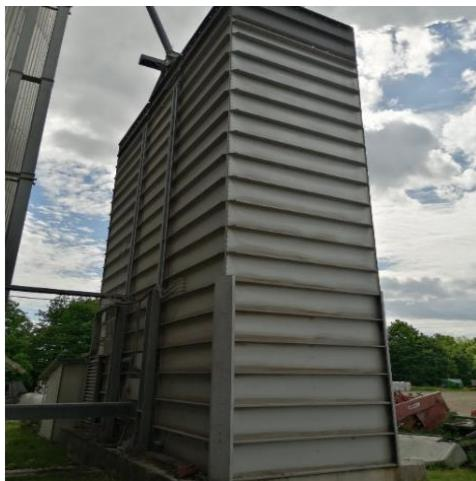
Sušara za žitarice je nabavljena i puštena u upotrebu 2006. godine. Sastoji se iz tri komore: komora za zagrijavanje – komora za žitarice – komora za ventilaciju. Kapacitet sušare je 144 t/24h.
